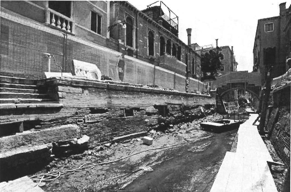
*un muro di sponda pubblico dove appare il degrado chimico fisico tipico della fascia intertidale*
